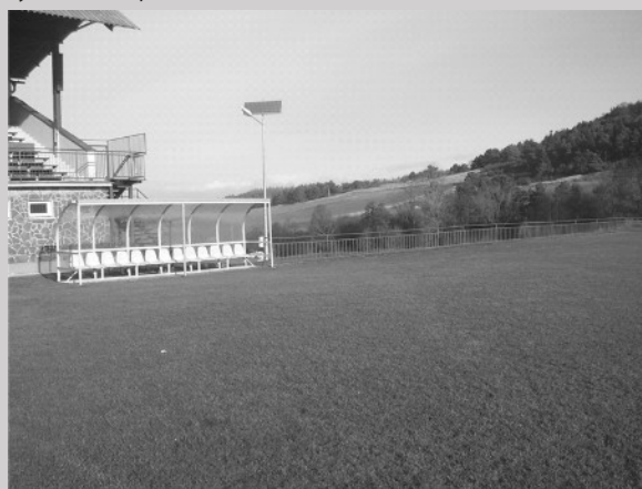
Oporný múr s novým zábradlím
