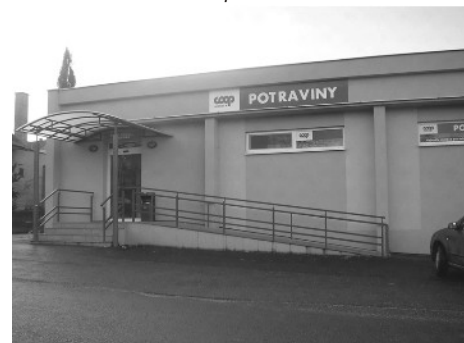
Zrekonštruovaná budova potravín
